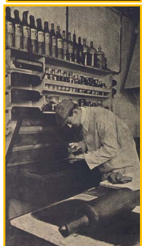
9 Protección con sangre de drago de las paredes de la plancha
