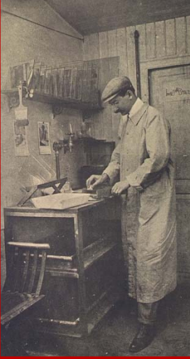
2 Vertido sobre el vidrio de una emulsión de colodión húmedo
