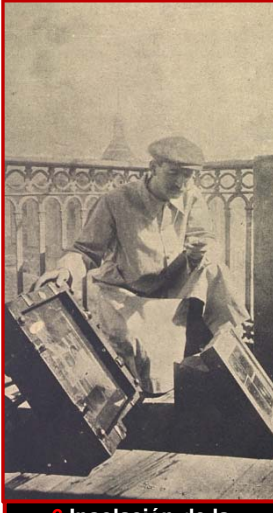
6 Insolación de la plancha de cinz con las películas de colodión tramadas
